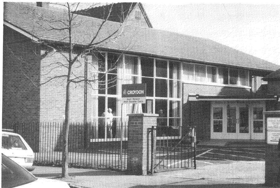
クロイドン区サウスノーウッドセンター
