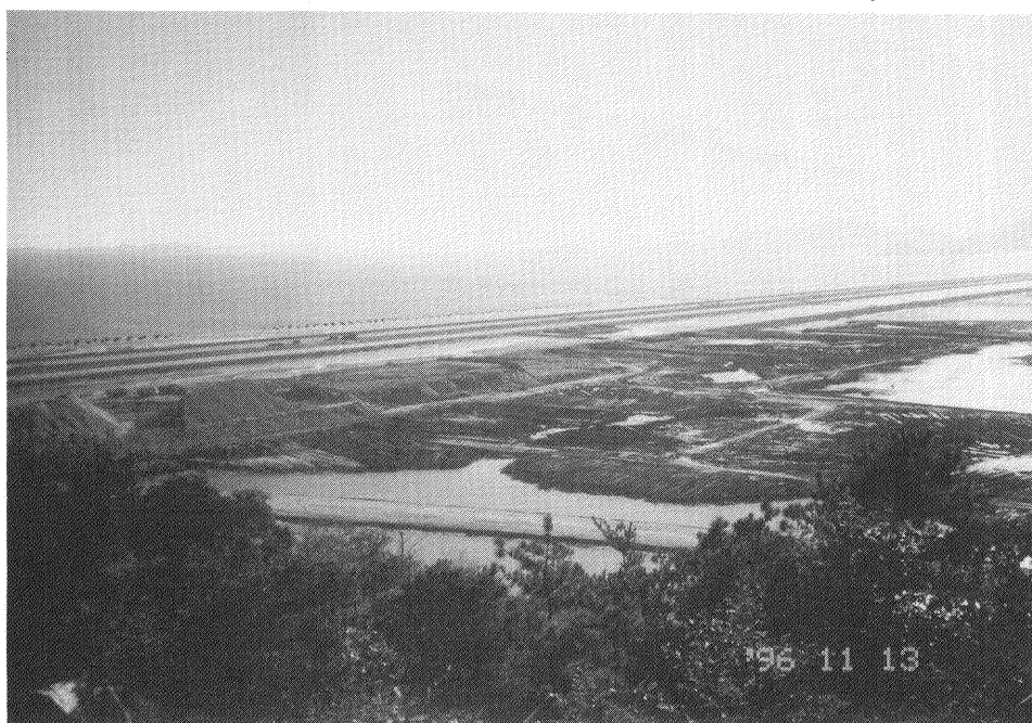
敷地造成風景
