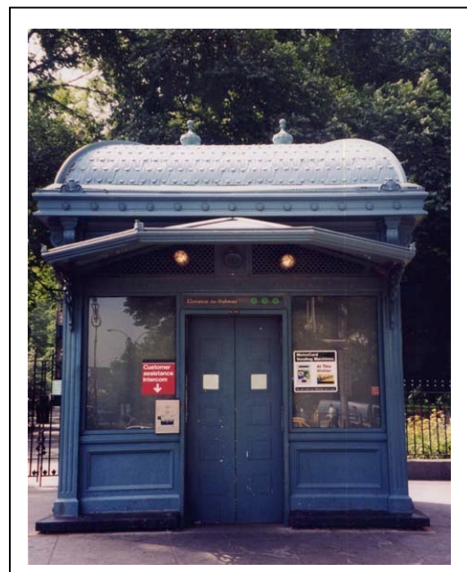
エレベーター（地上部分）
