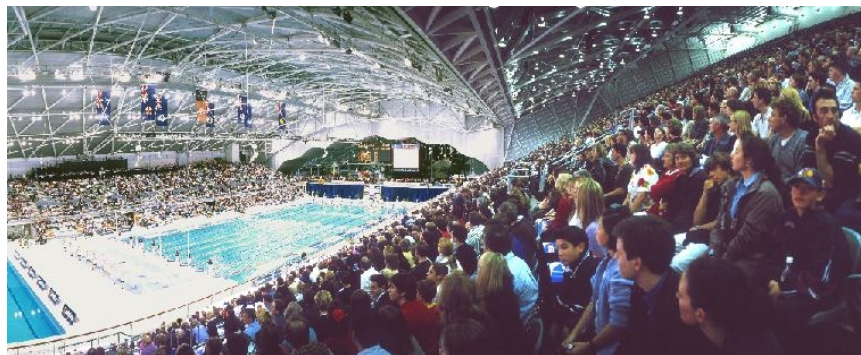
アクアティック・センター(右側傾斜は仮設スタンド)(©OCA)
