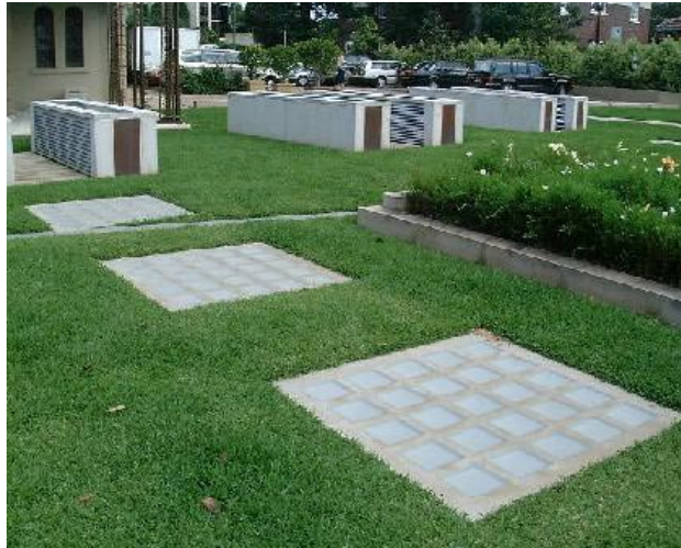
写真 48 議会庭園には地下オフィスの明り取り(ウーラーラ市内)
