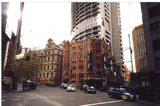
写真 61 奥に高層ビルを建設
