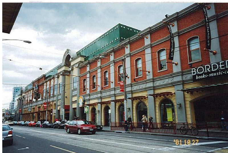
写真 63 レンガ壁の個性が活かされていない例(ストニントン市)
