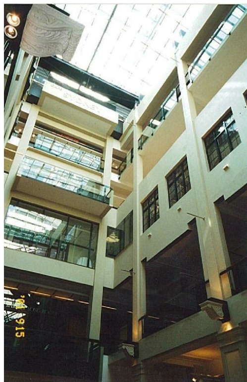
写真 28 大胆に改装した内部
