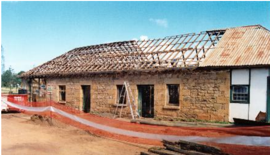
写真 27 売店も納屋を利用。改修工事の様子(提供:ペンリス市)
