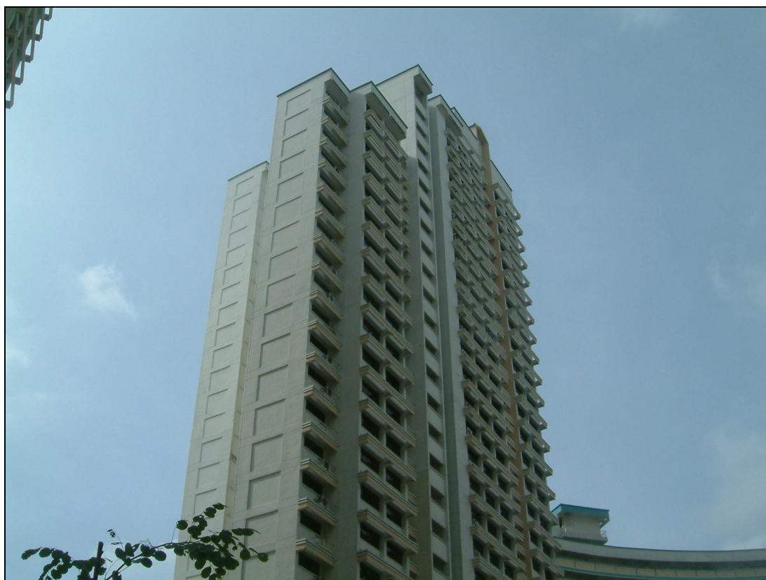
トア・パヨ地区の公共住宅。将来は更なる高層化が進むことになる。
