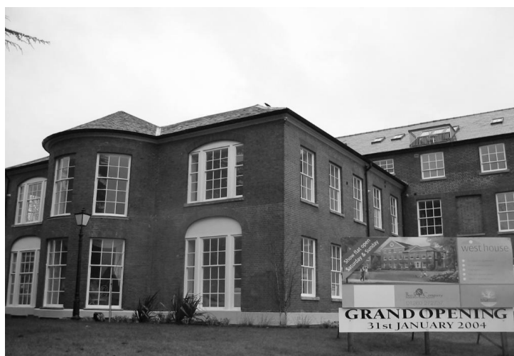
登録建物を再利用したフラット
