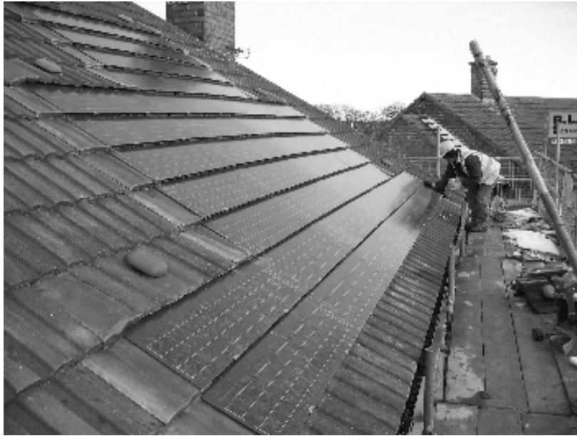
50 戸の住宅に順次敷設される太陽光発電用パネル (写真提供：エンバイロン)
