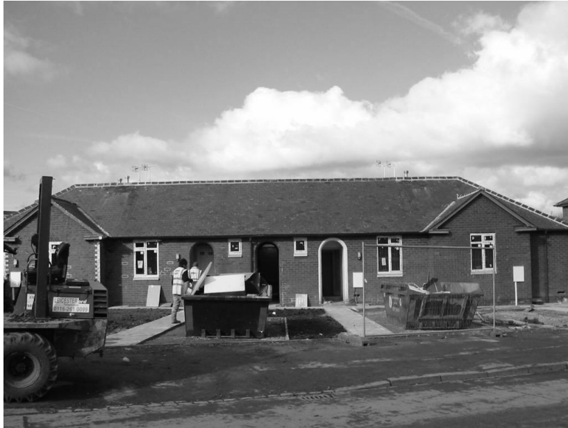
レスター住宅協会に移管された修繕工事中の住宅
