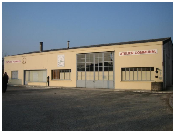
図 7 : 緊急出動センター (CPI) (左) とコミューンの作業場 (右)
