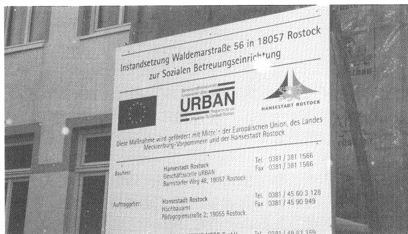
既存の建物をリハビリ施設に改修している。
