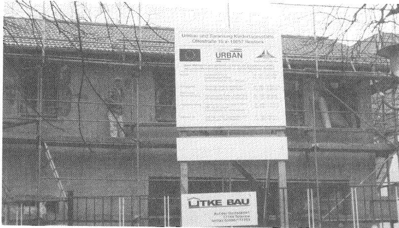
託児所の改修現場。
