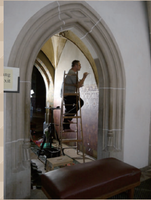
マイセン大聖堂内部 13世紀の建物であるため、補修作業も進められています。
