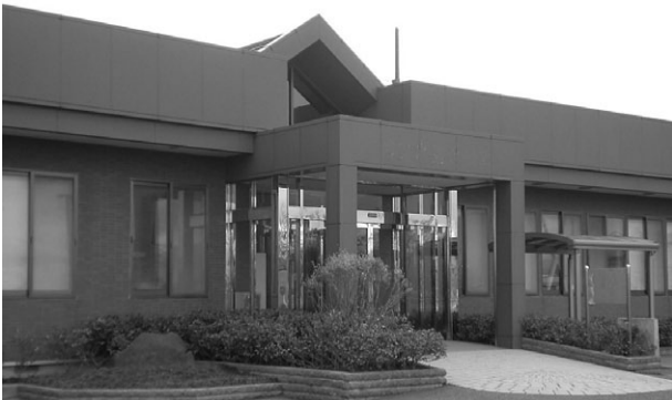
本社 事務所工場
