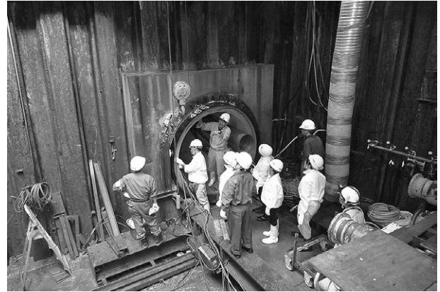
非開削工法（推進工法）視察
