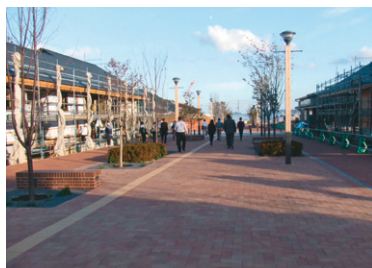
県内の復興事業(女川町の商店街建設)
