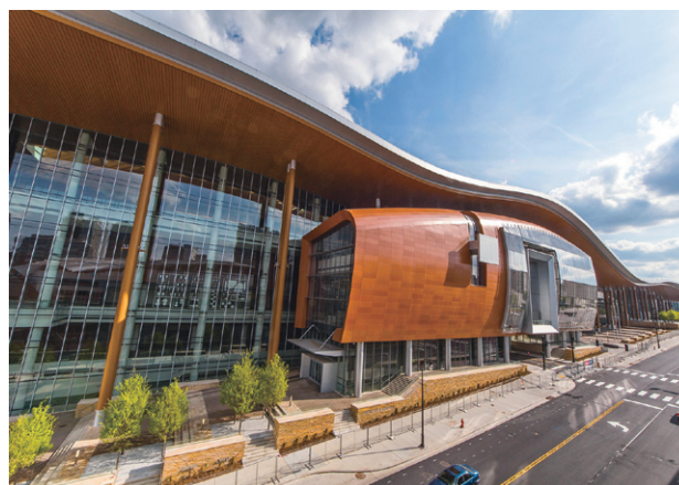
写真1 「Music City Center」の外観
