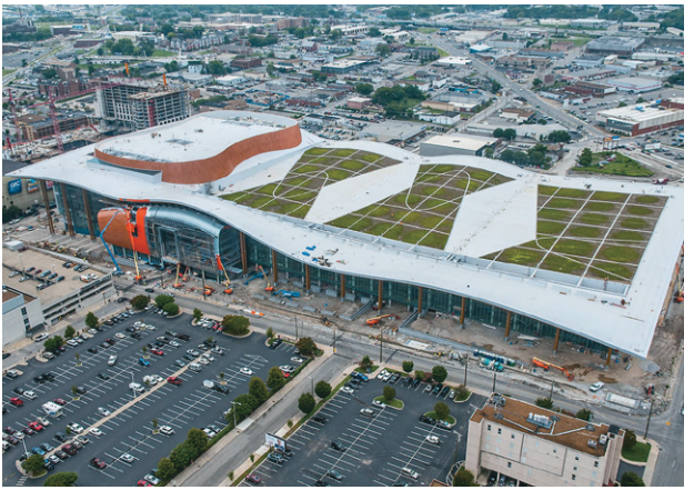
写真2 「Music City Center」に設置された グリーンルーフ (※)
