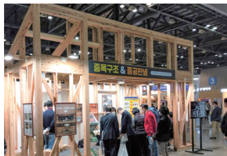
「木造軸組工法」による宮崎県ブース
