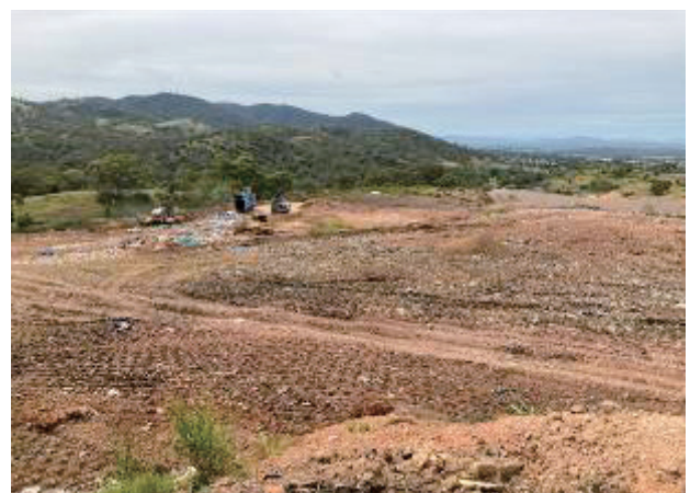
タムワース市内の埋立処理場の様子
