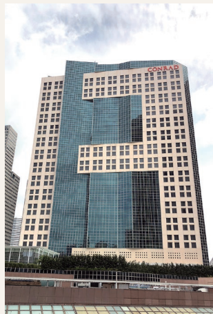
壁面に大きく「13」
