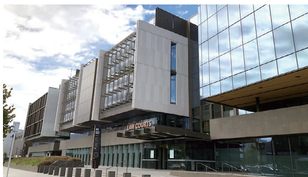
災害対応機関が入る合同庁舎
