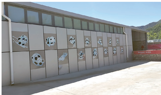
延慶冬奥展示中心の外観
