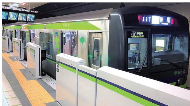
都内地下鉄駅のホームドア整備
