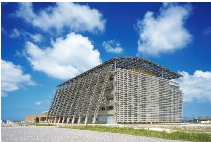
在南面及屋顶设置太阳能发电系统的市政厅建筑物 冲绳县糸满市
