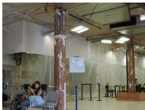
3-7 改装工事中のペルピニャン 空港ターミナル（2015,筆者撮影）
