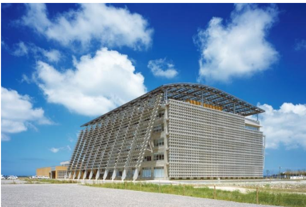
남향의 외벽과 옥상에 태양광 발전 시스템을 설치한 시청사 -오키나와현 이토만시
