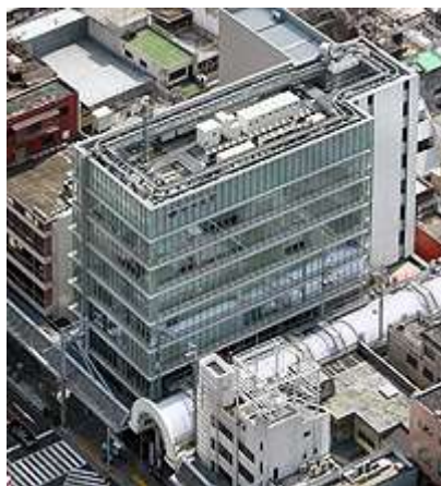
岐阜県国際交流センター外観
